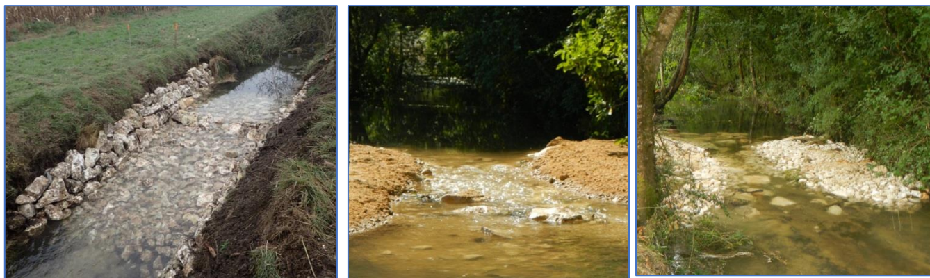
Figure 134 - Photographies d'aménagement de lutte contre l'incision
