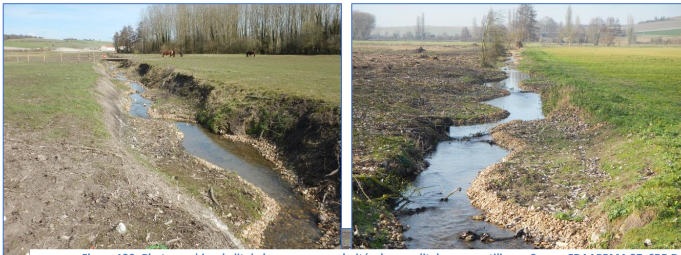
Figure 130 -Photographies de lit de basses eaux emboîtés dans un lit de crue rectiligne ; Source FDAAPPMA 37, SRB Dronne
