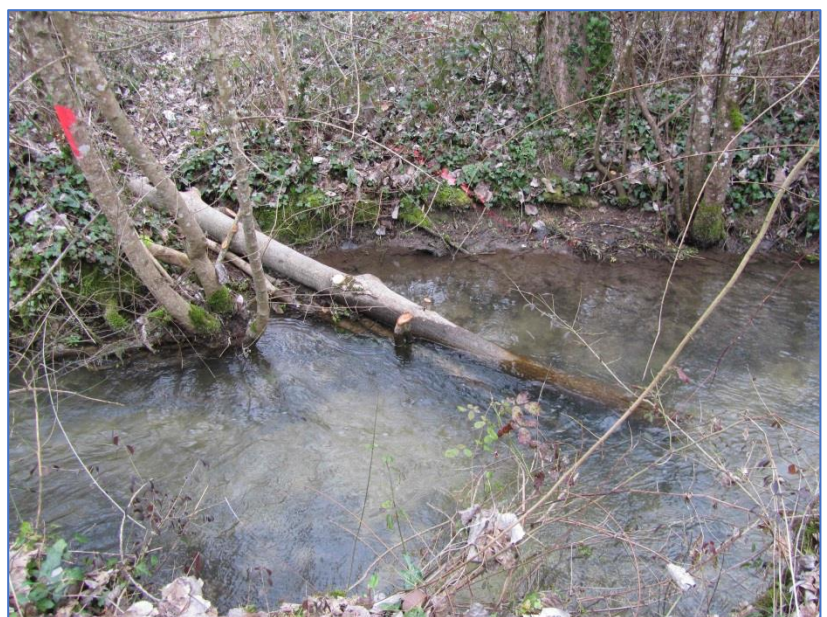
Figure 151 - Eléments de bois morts intégrés au lit mineur pour diversifier les écoulements
