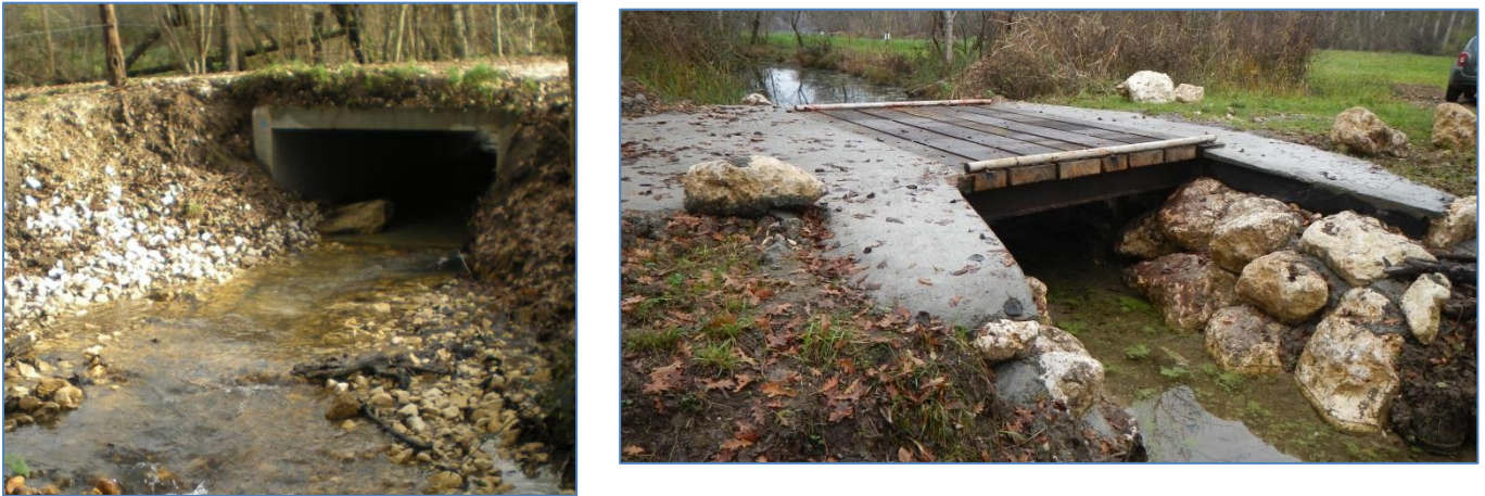
Figure 140 - Photographie d'un pont cadre et d'une passerelle
