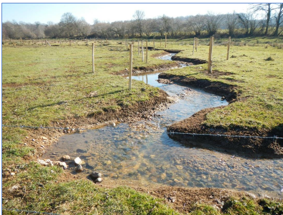
Figure 131 - Photographie d'un tronçon reméandré
