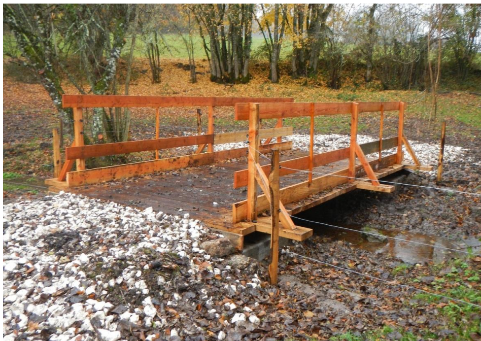
Figure 162 - Exemple de passerelle installée par le SRB Dronne
